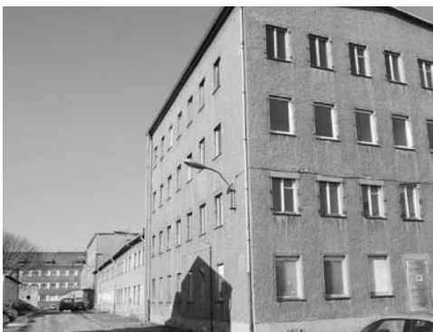
„Lager X“ (Blick Richtung Genslerstraße).
